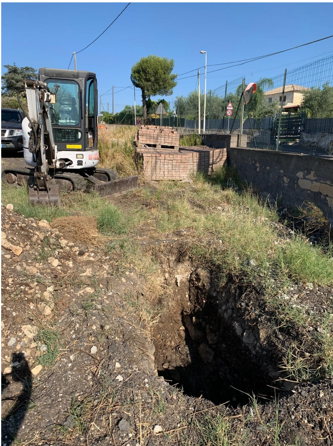
Figura 7 – Foto del pozzetto in cui è stata svolta la prova di permeabilità. Sullo sfondo l’escavatore meccanico che ha eseguito il pozzetto.
