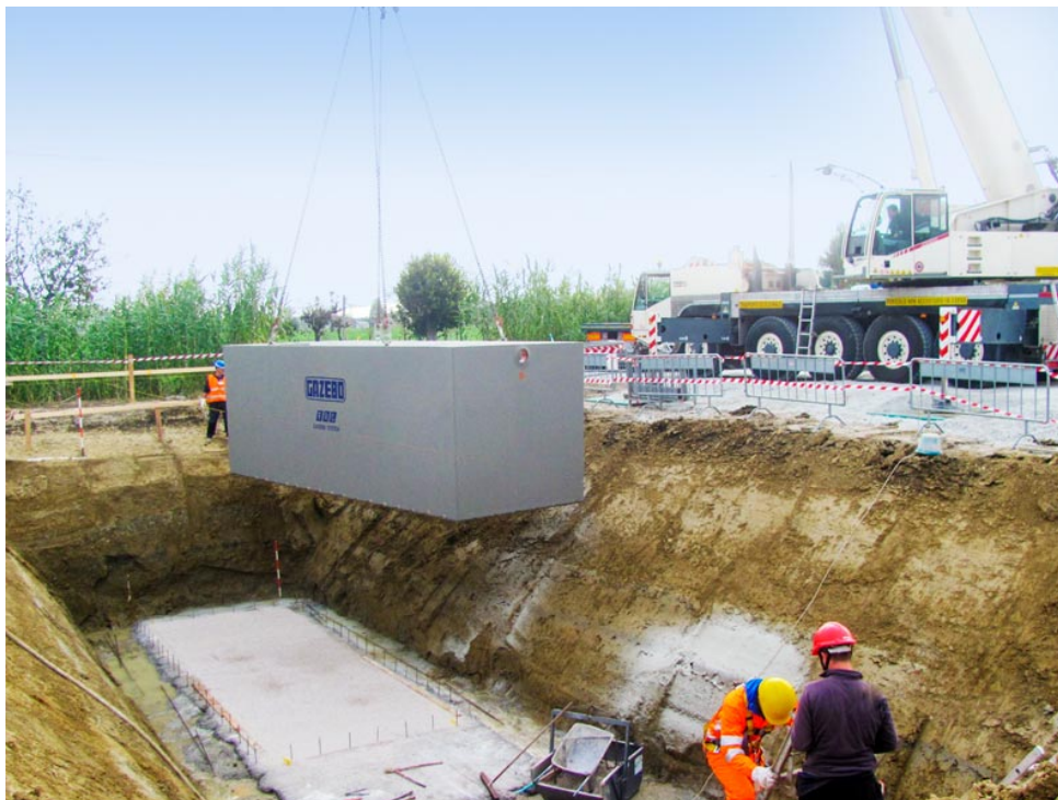
Esempio di vasca di laminazione prefabbricata
