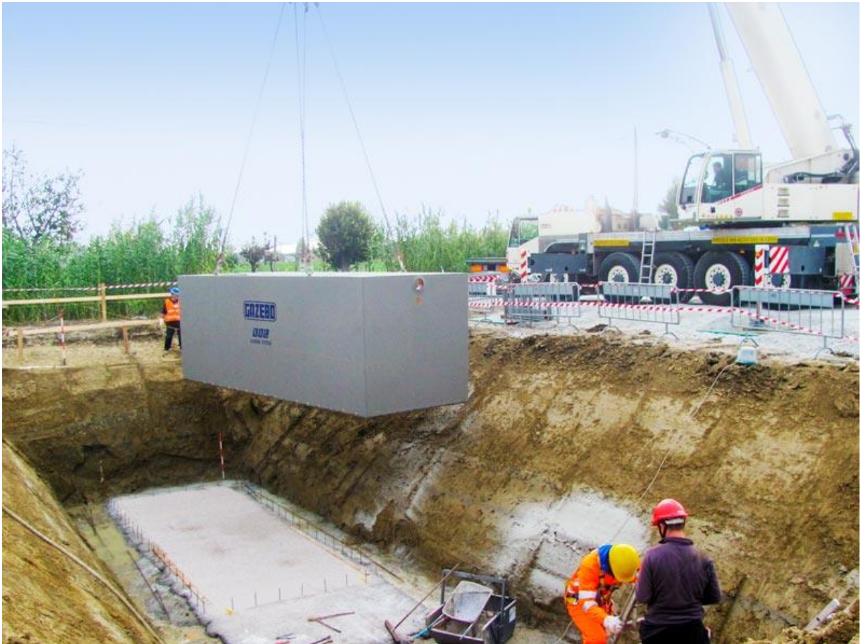
Esempio di vasca di laminazione prefabbricata
